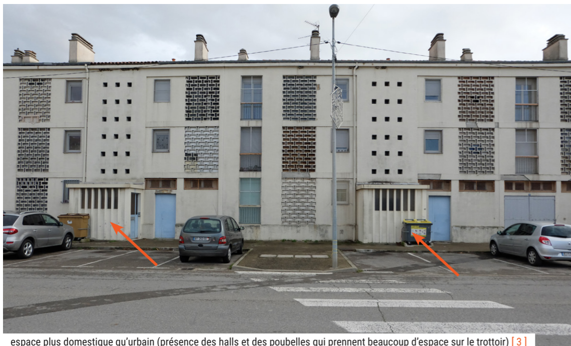
espace plus domestique qu'urbain (présence des halls et des poubelles qui prennent beaucoup d'espace sur le trottoir) [ 3 ]
