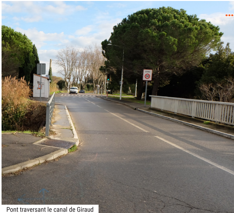
Pont traversant le canal de Giraud
