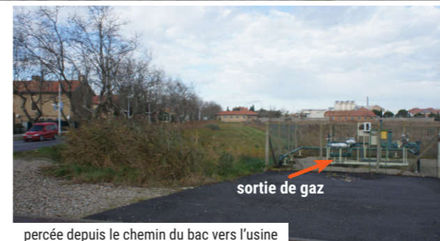
percée depuis le chemin du bac vers l'usine
