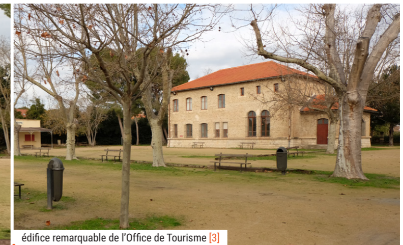
édifice remarquable de l'Office de Tourisme [3]
