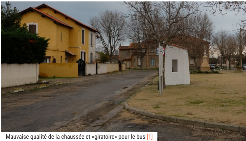
Mauvaise qualité de la chaussée et «giratoire» pour le bus [1]
